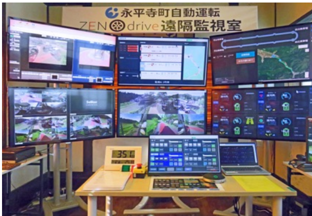
写真2 遠隔センター
